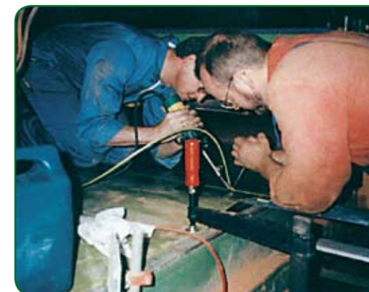
FK-4 Naprawa taśmy w miejscu jej zamontowania
