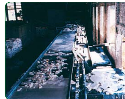
FEZ-2.5 Przetwarzanie sodu kaustycznego
